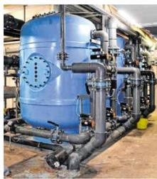
In den blauen Tanks befinden sich die Filter, mit denen das Beckenwasser des Hallenbads gereinigt wird.
